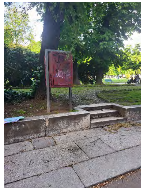
Immagine della pavimentazione prospiciente all'edificio denominato Chalet e Area Giochi per Bambini costituita da massetti autobloccanti in cemento
